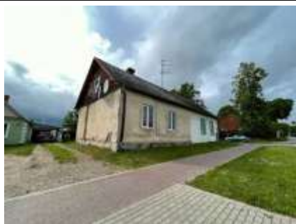
Dzīvojamā māja V. Seiles ielā 7
